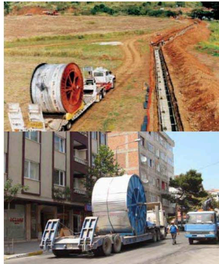
GFK – Rohrverlegung (li) und Erdverlegung (re o.) mit Kabeltransport bis zur Einbaustelle (re. u.)
