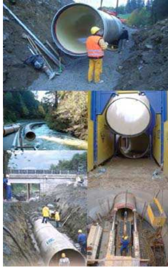
GFK – Rohrverlegung (li) und Erdverlegung (re o.) mit Kabeltransport bis zur Einbaustelle (re. u.)
